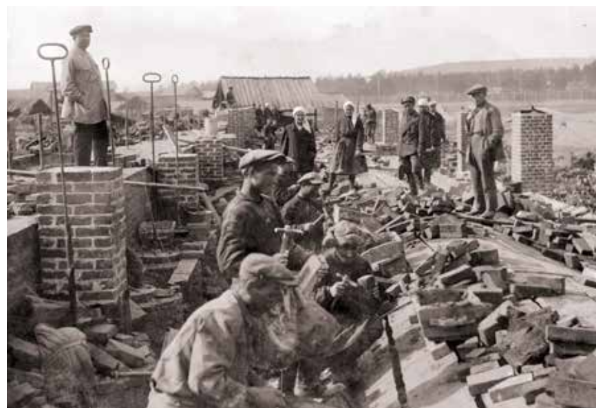
Строительство промышленных предприятий в г. Верхнеудинске
