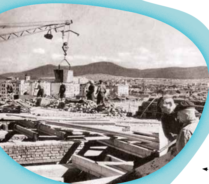
Строительство в г. Улан-Удэ
